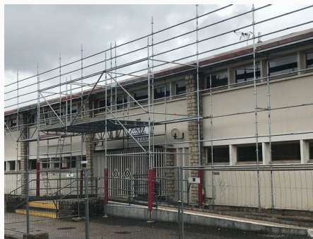
Désamiantage du groupe scolaire A. BRIAND à Sens
