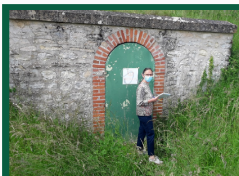
inspection d'un réservoir
