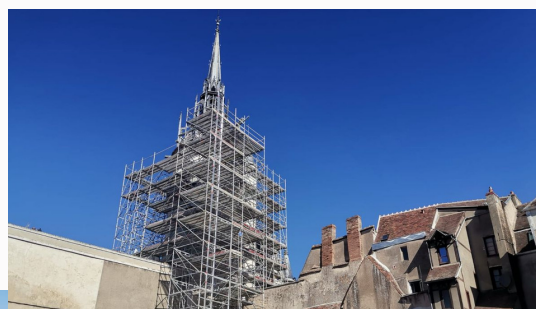
Rénovation de la tour de l'horloge à Auxerre
