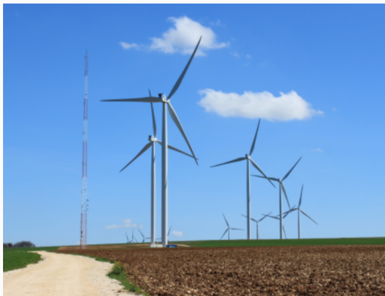
Parc éolien de Chitry/Quenne
